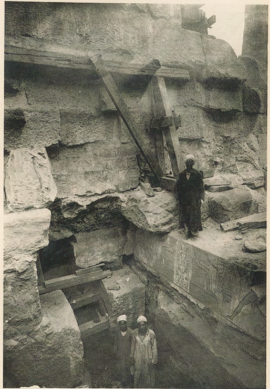
L'excavation de l'aile nord du III e pylône, pour la construction du premier contre-fort : on distingue nettement le grand bloc du monument de Toutmès II, en grès fin.
